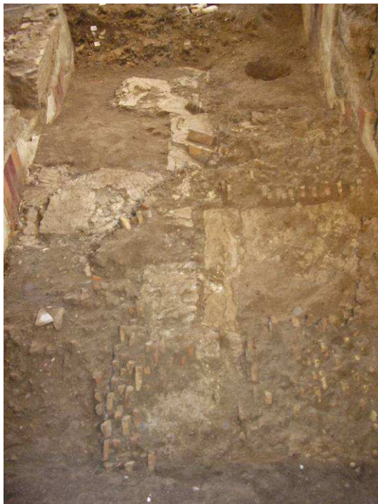
Fig. 4. Crollo all'interno del corridoio della parte superiore delle pareti nord e sud (foto Palladino-Paterna).
