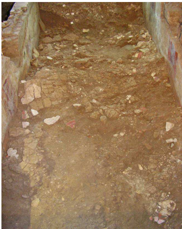
Fig. 23. Crollo del soffitto all'interno del corridoio (foto Palladino-Paterna).
